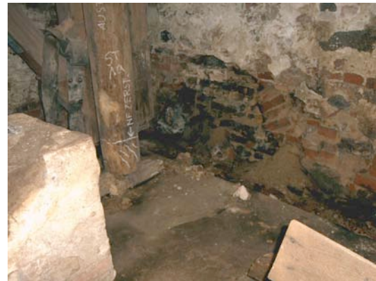
Wanddurchbruch für ehem. Wasserradwelle
