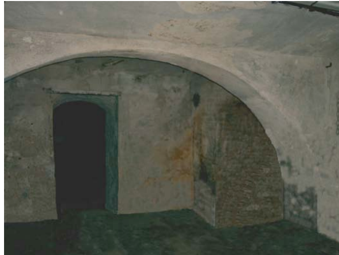
Kellergewölbe / Fundamente der Mühle
