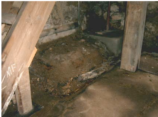
altes Lagerfundament der Wasserradwelle
