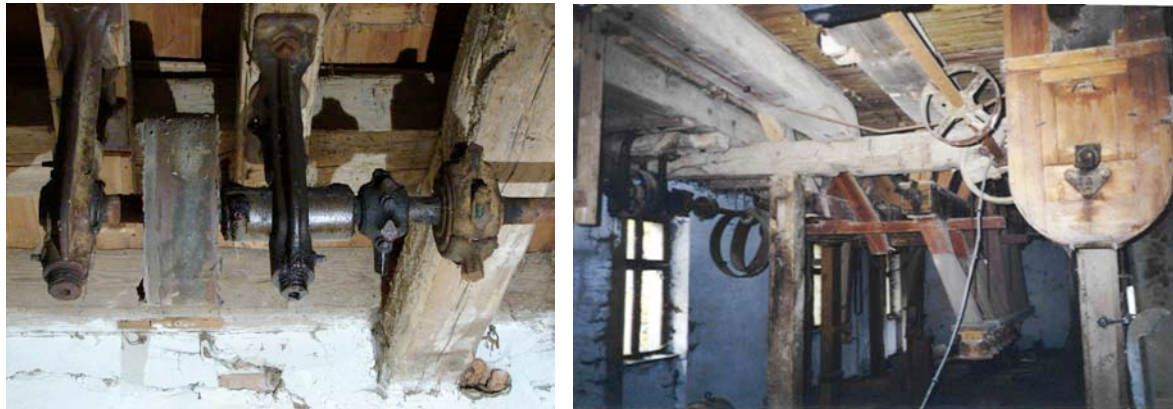
Transmissionen an den Geschosdecken
