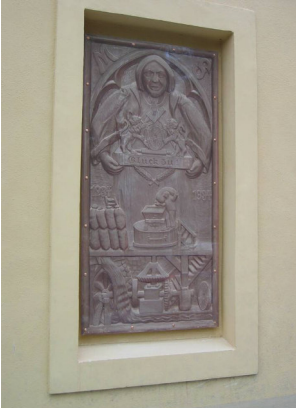
Am Mühlengebäude angebrachte Kopie der alten Schnitzerei
