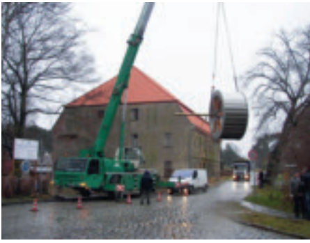
Dezember 2011: Der lang ersehnte Einbau des neuen Wasserrades mit einem Gewicht von 3 Tonnen Stahl
